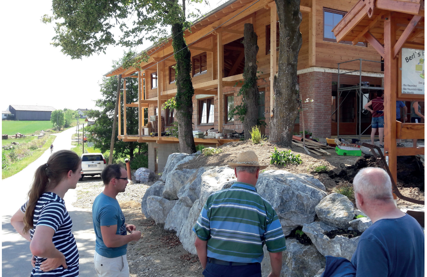
Markus Berl 2.v.l. führt durch das Gebäude, in dem die Käserei, der Reifekeller für den Käse und der Hofladen ihren Platz finden werden.
